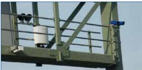
V-REX System mit 4 Kameras an einer Schilderbrücke befestigt
